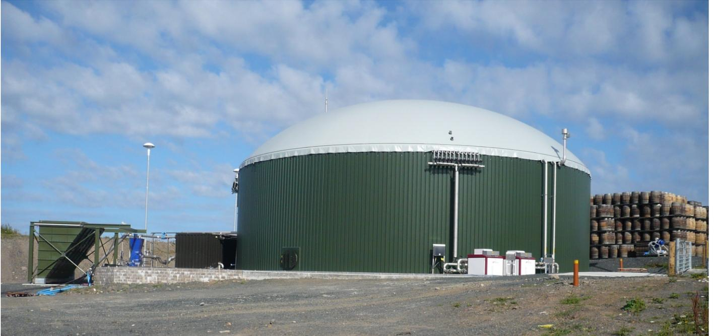
Planta BIOLAK<sup>®</sup>GAS Solid para destilería, aprox. 4.500 t/a orujos de Whisky, 650 kW/h
